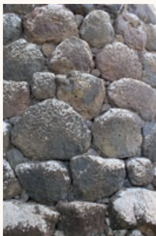
Nuraghe Su Nuraxi, tecnica costruttiva a filari di basalto del paramento esterno
