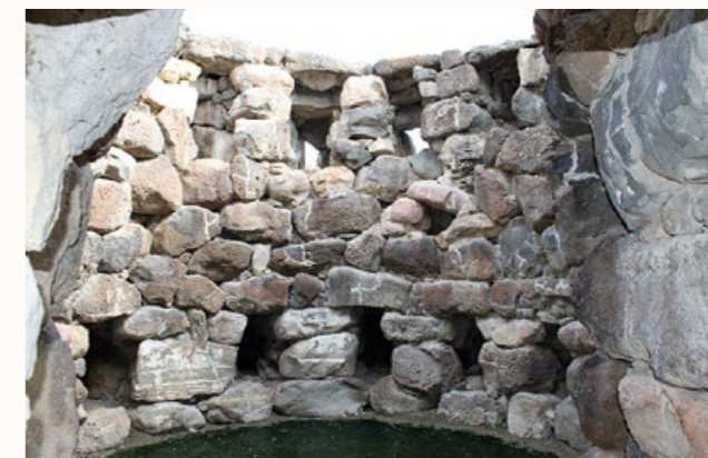
Nuraghe Su Nuraxi, antemurale, torre H, in evidenza i due ordini di feritoie
