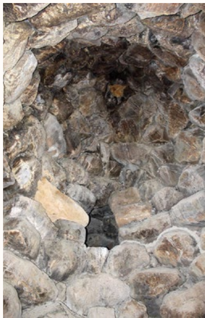
Nuraghe Su Nuraxi, camera del piano-terra del mastio (A), particolare della volta a falsa cupola e accesso sopraelevato alle scale di camera
