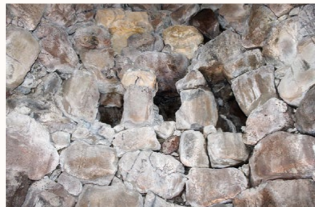
Nuraghe Su Nuraxi, torre nord (D ), camera del piano- terra, particolare dell'ordine superiore delle feritoie
