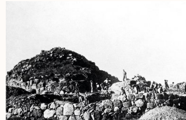
Le operazioni di scavo del nuraghe Su Nuraxi (1951-1956)
