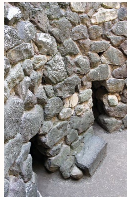
Nuraghe Su Nuraxi, veduta dall'alto sull'ingresso alla torre sud (F), a destra, e sull'ingresso originario del bastione quadrilobato nella cortina sud- orientale, a sinistra
